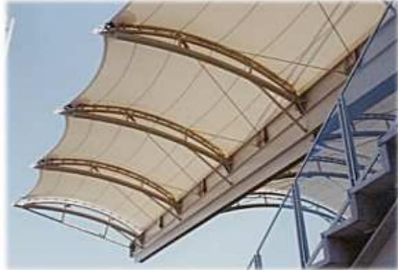
Structure : BA pour les gradins bas, BA et métal pour les gradins hauts, Métal et Toile Tendue pour la couverture, avec des porte-à-faux de 35 m.
