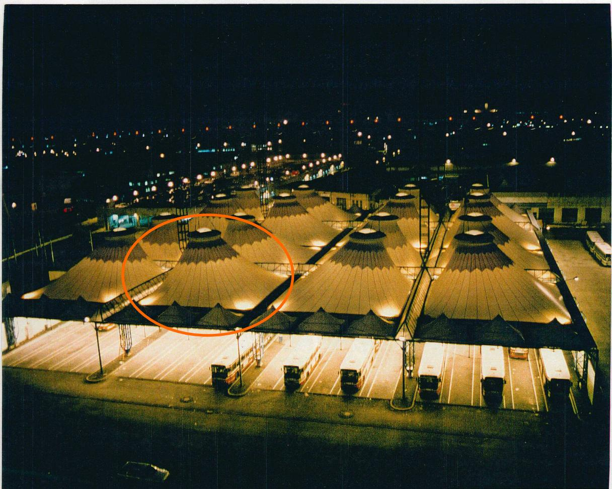
C'est en fait un tore en tube métallique. La toile est lassée dessus et elle est maintenue par des haubans fixés à un mat.
